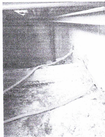
Foto 62, 63 e 64 – Item 02.03 Abertura e fechamento de rasgos em alvenaria, para passagem de eletroduto diâm. 1 1/4" a 2" e item 05.03 Eletroduto flexível corrugado 1", marca de referência TIGRE – Telhado
