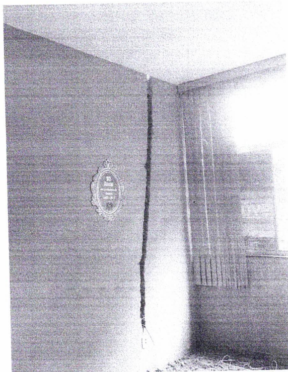
Fotos 30 e 31 – Itens 02.02, 03.01, 03.02 e 03.03 – Raspagem para remoção de craquele de pintura, chapisco e reboco de argamassa de cimento e emassamento – Circulação
