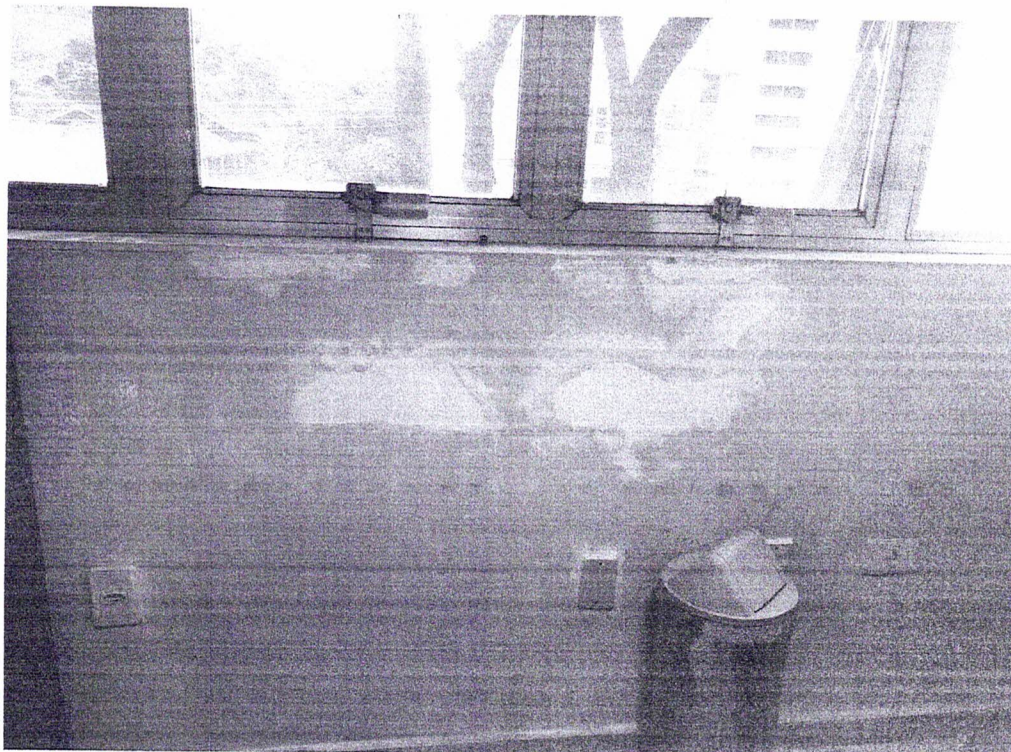
Foto 14 – Itens 02.02, 03.01, 03.02 e 03.03 – Raspagem para remoção de craquele de pintura, chapisco e reboco de argamassa de cimento e emassamento – Ouvidoria
