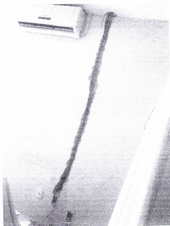
Fotos 32 e 33 – Item 02.03 – Abertura e fechamento de rasgos em alvenaria para passagem de eletroduto e Item 05.03 Eletroduto flexível corrugado 1", marca de referência TIGRE e Item 07.02.01 Fornecimento e instalação de Cabo de rede par trançado 4 pares Categoria 5e – Rasgo
