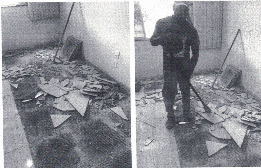
Foto 06 e 07 – Itens 02.04 Demolição de piso revestido com cerâmica
