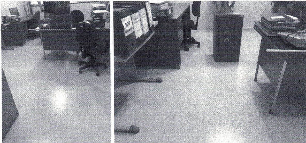
Foto 17 e 18 – Item 04.01 REVESTIMENTO CERÂMICO PARA PISO COM PLACAS TIPO PORCELANATO DE DIMENSÕES 60X60 CM APLICADA EM AMBIENTES DE ÁREA MAIOR QUE 10 M 2 . AF_06/2014, Item 04.03 Rodapé de porcelanato, assentado com argamassa de cimento cola h = 7.0 cm, inclusive rejuntamento com cimento branco – Financeiro
