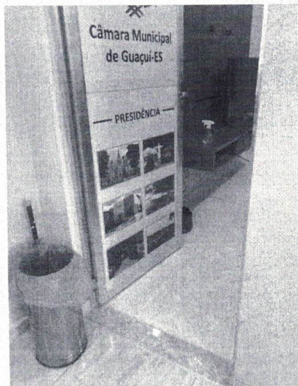
Foto 25 – Item 04.04 SOLEIRA EM GRANITO, LARGURA 15 CM, ESPESSURA 2,0 CM. AF_09/2020 - Presidência
