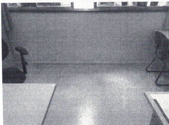
Foto 21 e 22 – Item 04.03 Rodapé de porcelanato, assentado com argamassa de cimento cola h = 7.0 cm, inclusive rejuntamento com cimento branco – Diretoria do Legislativo
