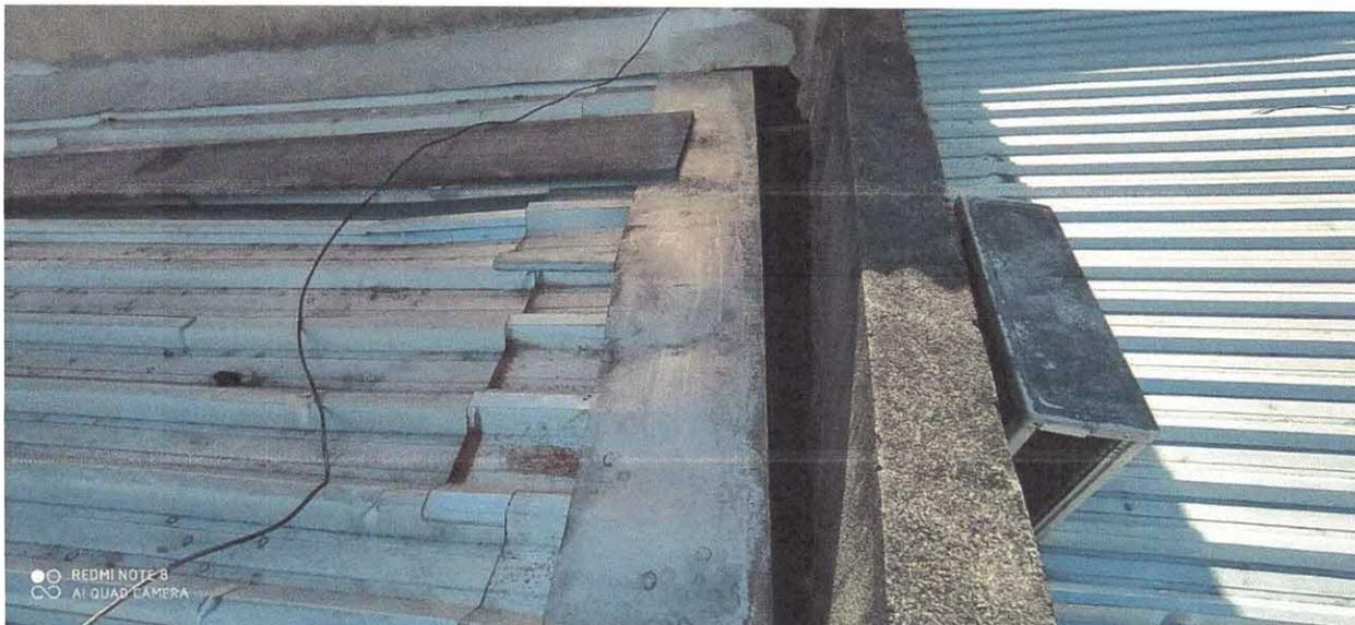
**Foto 03 – Problema da telha mal colocada**
