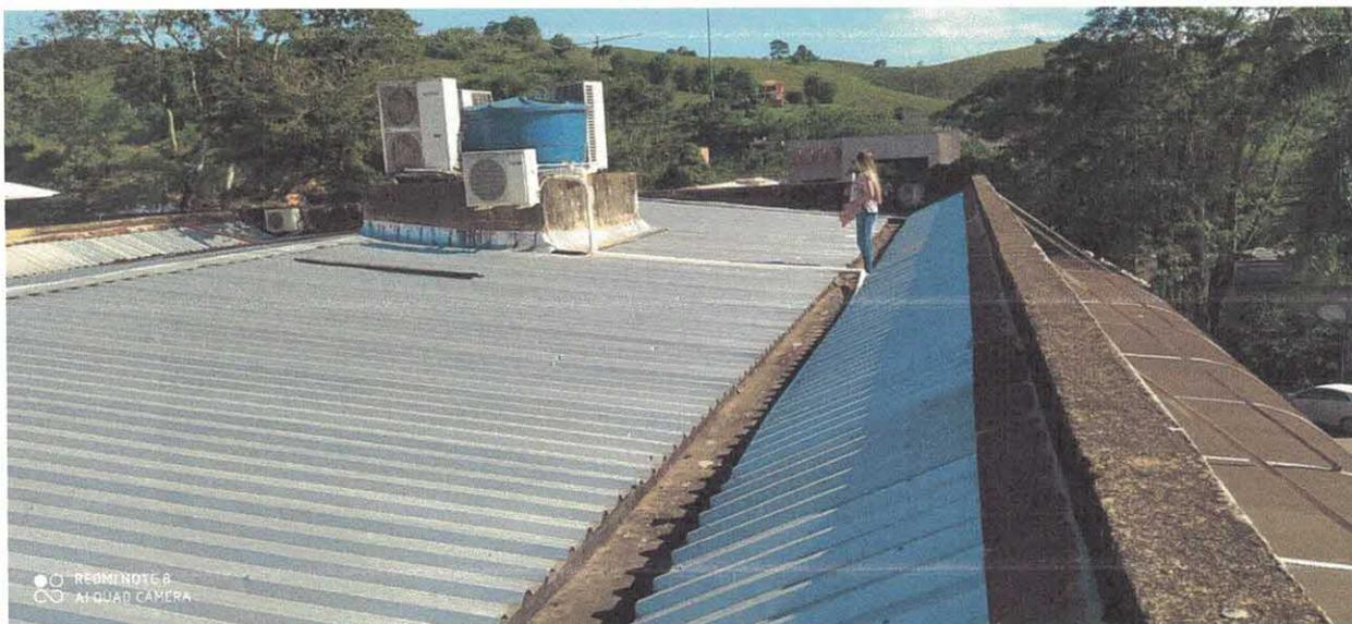
**Foto 04 – Detalhe da laje de apoio da caixa D'água que está causando infiltração**
